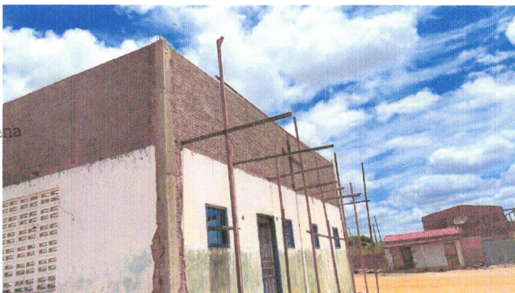
FOTO 05 – ALVENARIA DE VEDAÇÃO DE BLOCOS CERÂMICOS FURADOS NA HORIZONTAL DE 9X19X29 CM (ESPESSURA 9 CM) E ARGAMASSA DE ASSENTAMENTO COM PREPARO EM BETONEIRA. AF_12/2021
