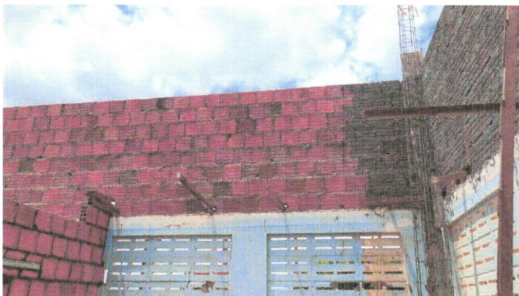
FOTO 05 – ALVENARIA DE VEDAÇÃO DE BLOCOS CERÂMICOS FURADOS NA HORIZONTAL DE 9X19X29 CM (ESPESSURA 9 CM) E ARGAMASSA DE ASSENTAMENTO COM PREPARO EM BETONEIRA. AF_12/2021
