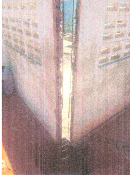
Foto 19 - Escavação manual para bloco de coroamento ou sapata (sem escavação para colocação de fôrmas). Af_06/2017
