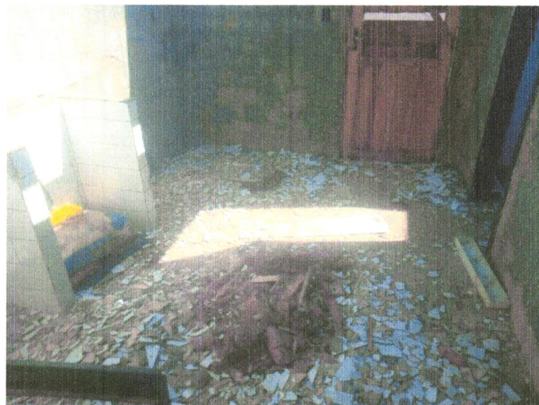
FOTO 04 - Demolição de revestimento cerâmico ou azulejo
