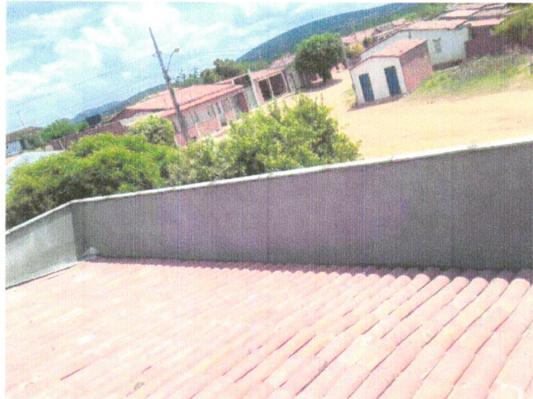
Foto 07- CALHA EM CHAPA DE AÇO GALVANIZADO NÚMERO 24, DESENVOLVIMENTO DE 33 CM, INCLUSO TRANSPORTE VERTICAL. AF_07/2019
