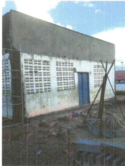
Foto 15 - MASSA ÚNICA, PARA RECEBIMENTO DE PINTURA OU CERÂMICA, ARGAMASSA INDUSTRIALIZADA, PREPARO MECÂNICO, APLICADO COM EQUIPAMENTO DE MISTURA E PROJEÇÃO DE 1,5 M 3 /H EM FACES INTERNAS DE PAREDES, ESPESSURA DE 5MM, SEM EXECUÇÃO DE TALISCAS. AF_06/2014
