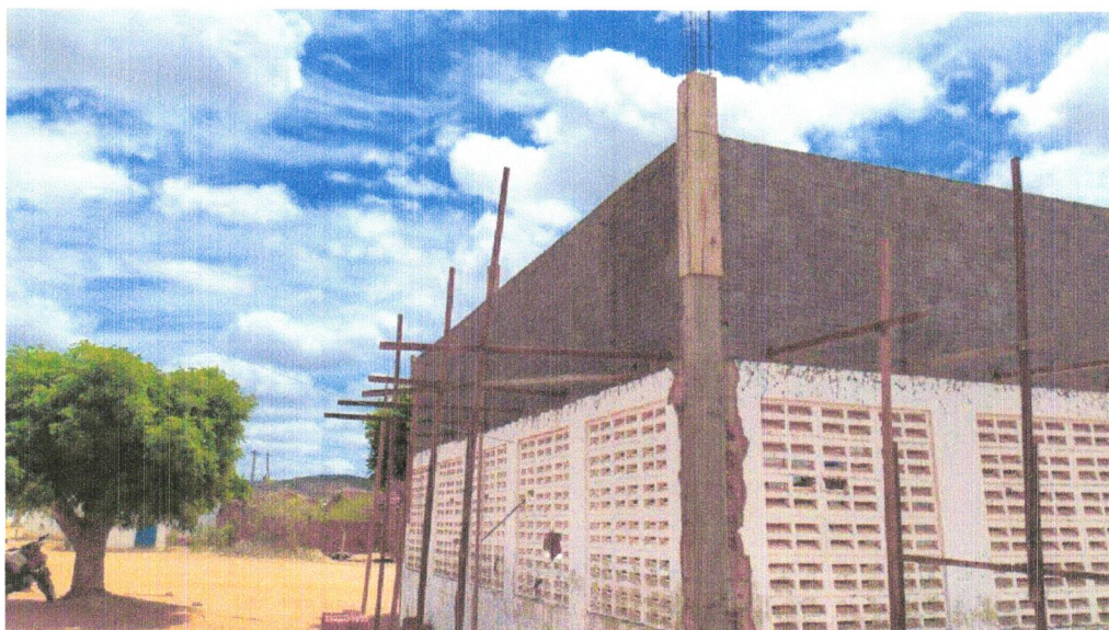
FOTO 12- (COMPOSIÇÃO REPRESENTATIVA) EXECUÇÃO DE ESTRUTURAS DE CONCRETO ARMADO, PARA EDIFICAÇÃO HABITACIONAL UNIFAMILIAR TÉRREA (CASA EM EMPREENDIMENTOS) FCK=25MPA. AF_01_01/2017
